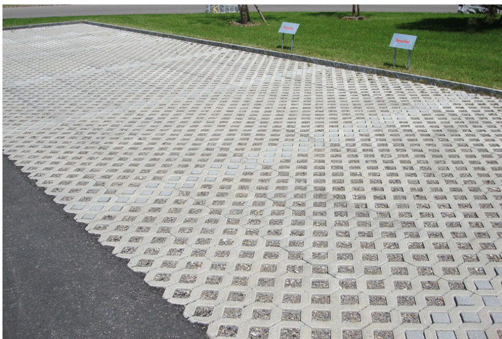
Figura 30. Esempio di pavimentazione drenante. Archiexpo.it
