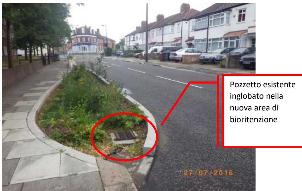
Figura 36. Esempio di retrofitting stradale con creazione di una area di bioritenzione con al suo interno il pozzetto stradale esistente, recuperato con funzione di troppo pieno. Sudrain.org
