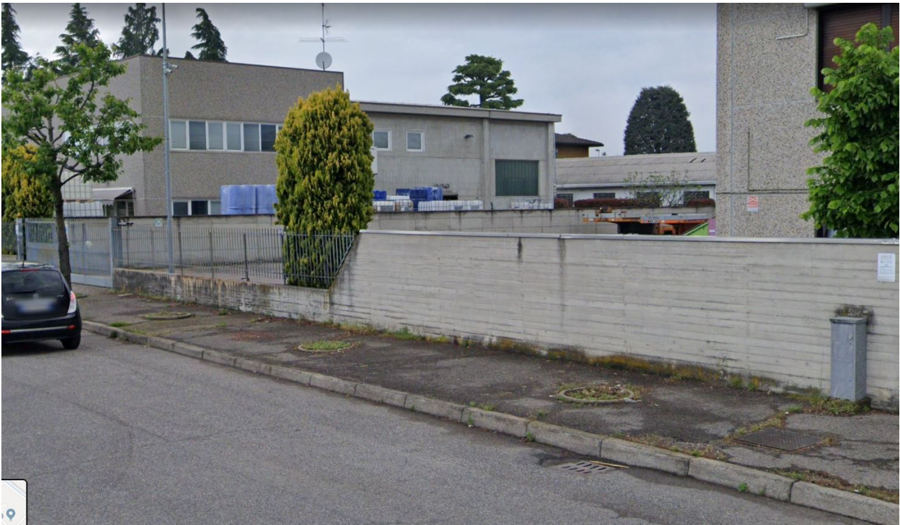
Figura 48. Statto attuale marciapiedi lato nord in Via Lombardia, Città di Parabiago. Estratto da Google Earth
